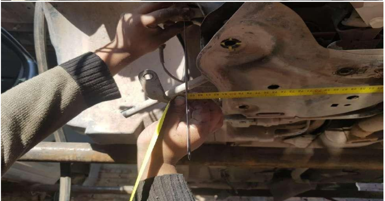
MEDIDA DE ANCHO CUNA DE MOTOR CENTRO A CENTRO SUJECCION DE LARGUERO DE CARROCERIA (855 MM).
